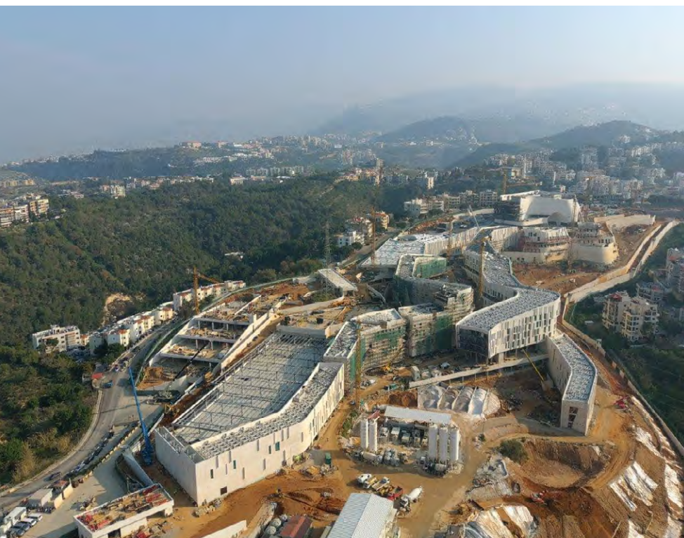
建设中的美国驻黎巴嫩使馆新馆。
